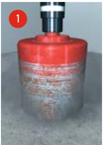
Kernbohrung erstellen Alternativ: Die passende Deckendurchführung aus Styropor
