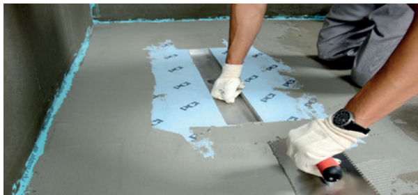
Verbundabdichtung nach DIN 18534
